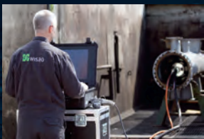
Roboter punkten bei der Reinigung und Instandhaltung von Kanälen und Rohrleitungen.
