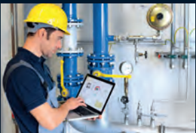
Cloudbasierte Zustandserfassung in der Druckluft.
